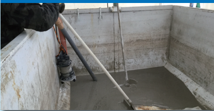
CKバキュームを使用し、石綿スラッジの回収作業 ②・③・④・A
